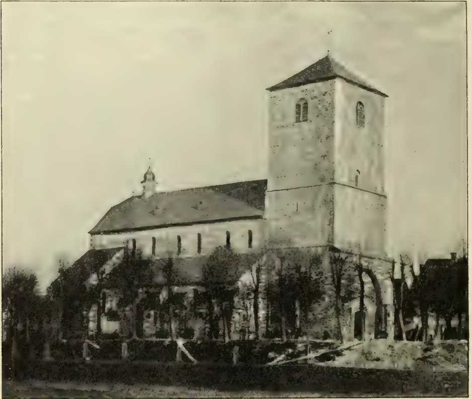
Fig 68 Wipperfürth. Ansicht der katholischen Pfarrkirche vor der Wiederherstellung.
